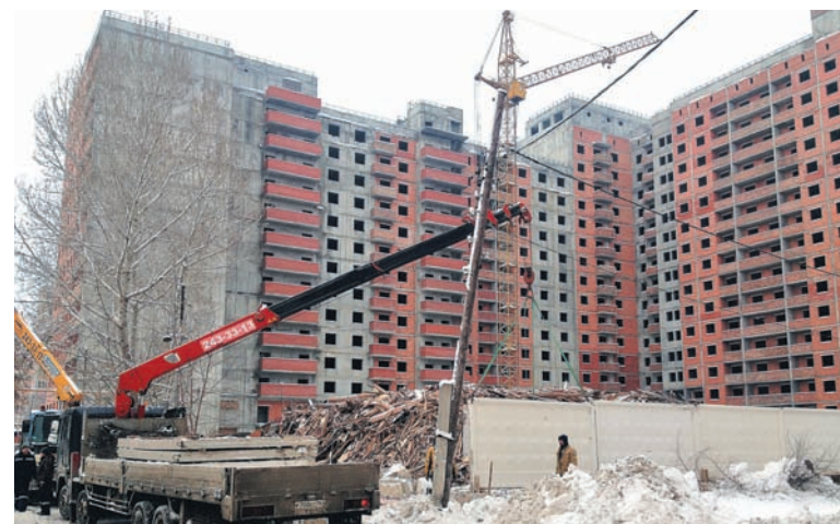
УЧАСТОК УЖЕ ОГОРОЖЕН БЕТОННЫМ СТРОИТЕЛЬНЫМ ЗАБОРОМ, А БУЛЬДОЗЕР ПРОДОЛЖАЕТ ОЧИЩАТЬ ТЕРРИТОРИЮ ОТ ОСТАТКОВ ДЕРЕВЯННОГО ДОМА
